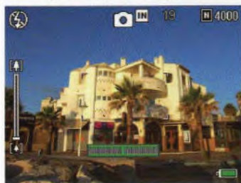
Avec mise à niveau
